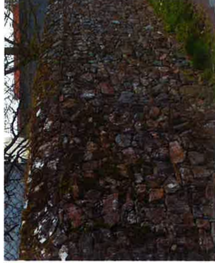
Murs en moellons terminés par un chanfrein
