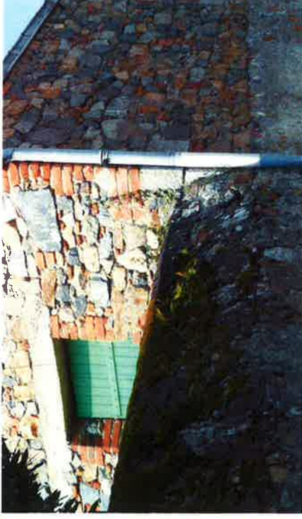
Mur de clôture et dépendance sommairement enduits
